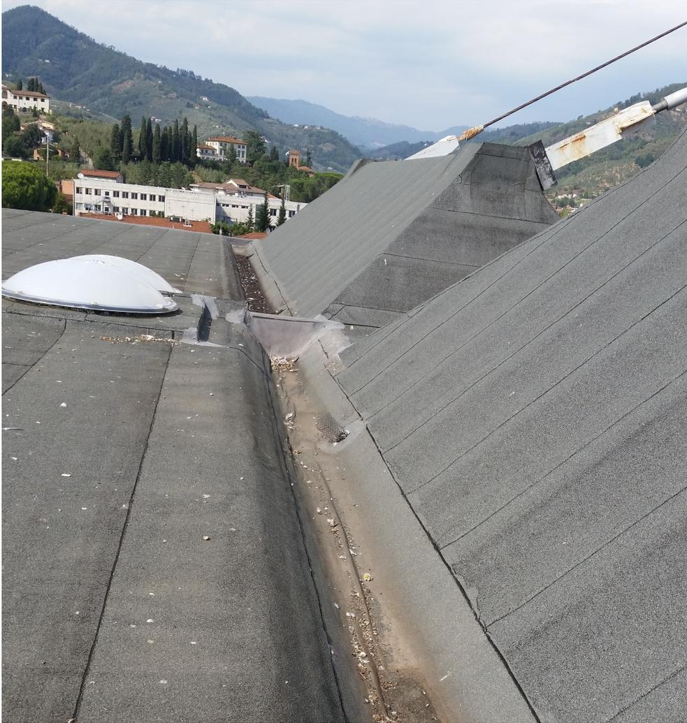
Nel dettaglio le lavorazioni di impermeabilizzazione dei quattro canali posti in copertura di raccolta e convogliamento delle acque meteoriche saranno le seguenti:
