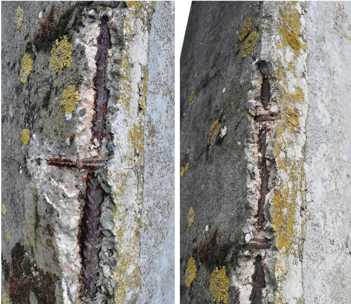
La progressiva aggressione delle armature per effetto del distacco del copriferro ha fatto sì che il fenomeno interessasse un lungo tratto intorno a questo punto di cambio di sezione e che va a rastremare verso l'alto.
