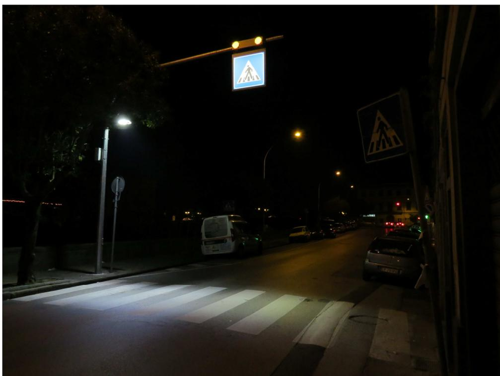
**Figura 3: Esempio di attraversamento pedonale protetto – Viale Forti**
