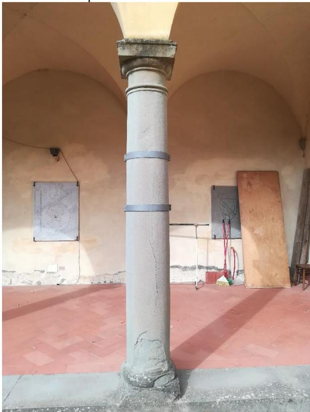
CA3. La colonna 2 dove sono evidenti lesioni di distacco superficiale del materiale e fasce di contenimento in ferro.
