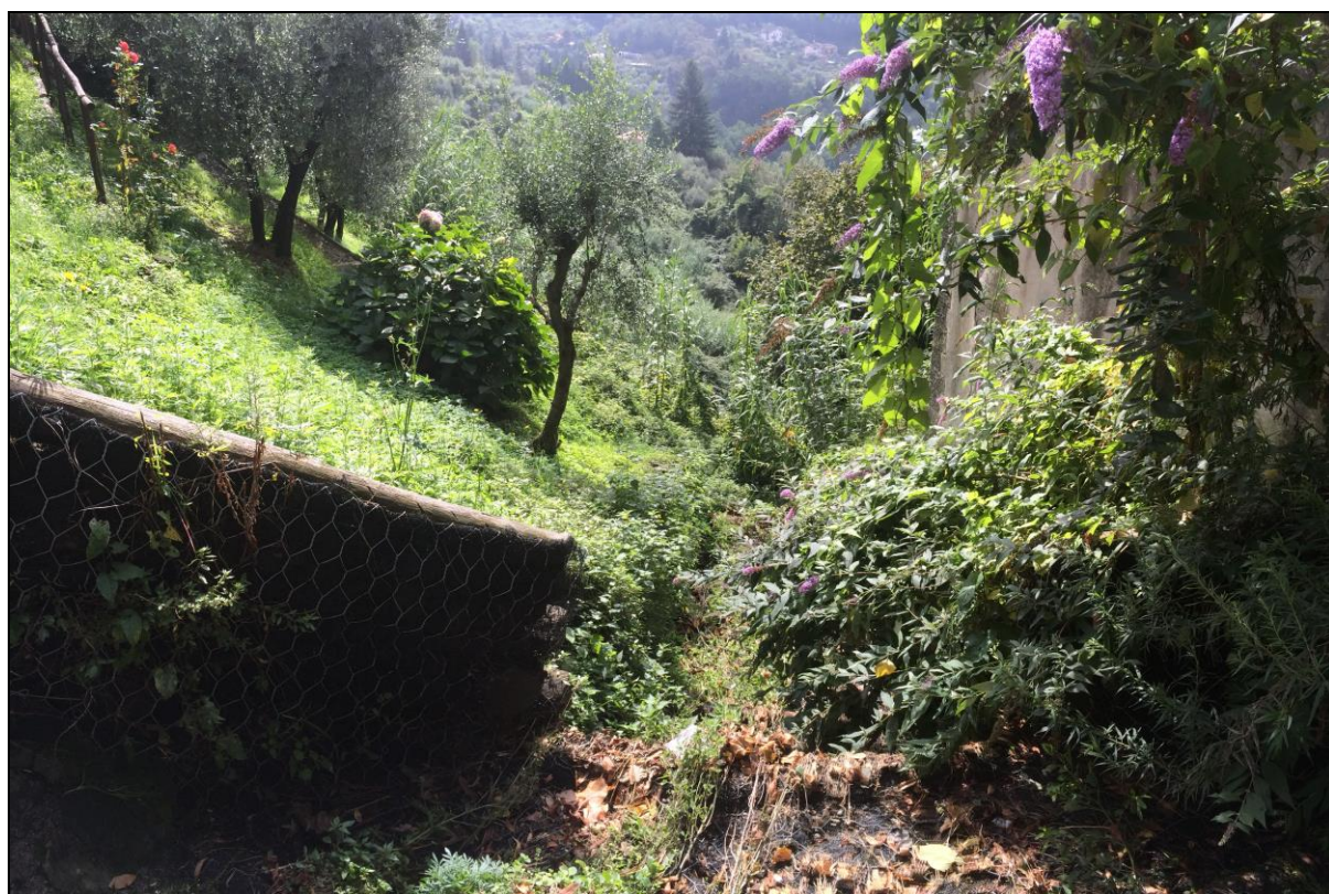
Foto n.7 Vista del Canale della Mora in alveo.
